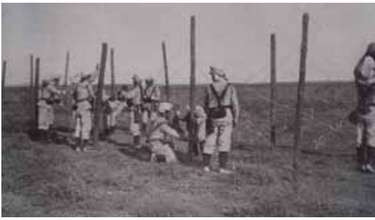
Soldados de infantería construyendo las alambradas en los límites del campamento español.
