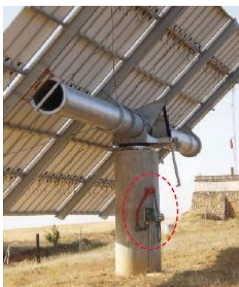
Figura 47. Caja de conexiones de un módulo fotovoltaico. Fuente: Ramírez, 2008.
