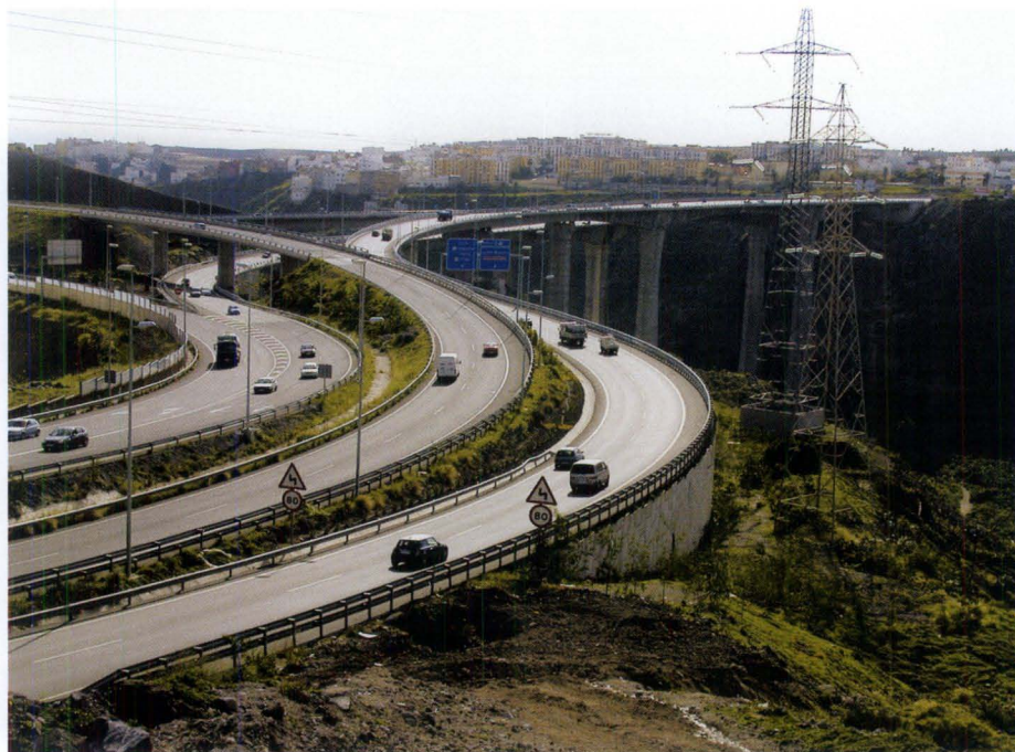
Imagen 3. Viaducto de la circunvalación de la ciudad de Las Palmas de Gran Canaria. Image 3. Viaduc du périphérique de la ville de Las Palmas de Gran Canaria.
