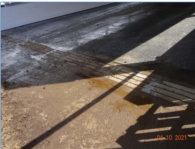
Figura 6. Rejas recogida aguas limpieza rampa ordeño
