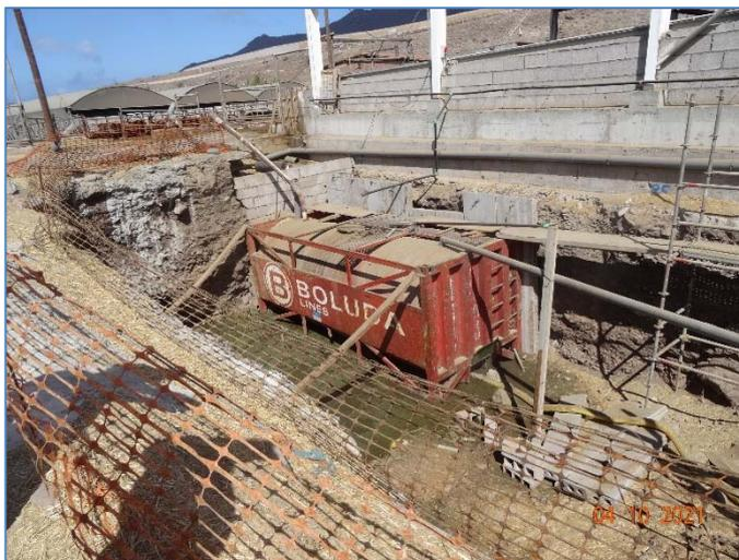
Figura 8. Contenedor recogida aguas residuales
