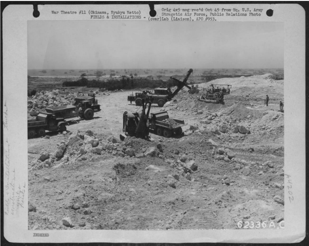
Figura 26. Reacondicionamiento del aeródromo de Kadena, 17 de mayo de 1945.
