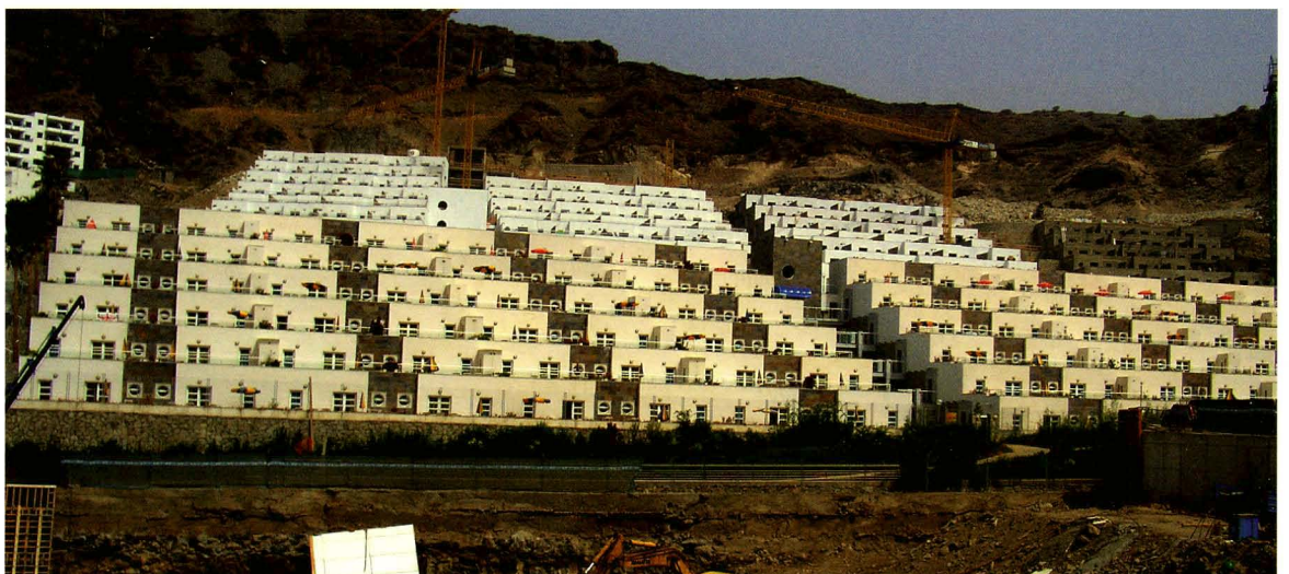
Edificación intensiva turística. Puerto Rico. Gran Canaria.
