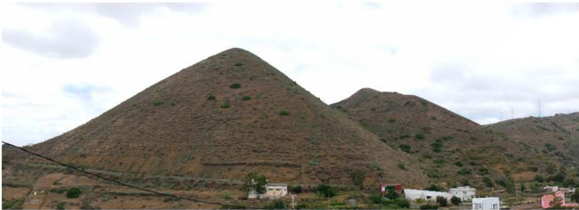
Figura 5.77: Vista general del flanco Norte del edificio de Montaña Pelada. Se observa desventrado el edificio en la parte central respecto al flanco situado en segundo plano de esta imagen.
