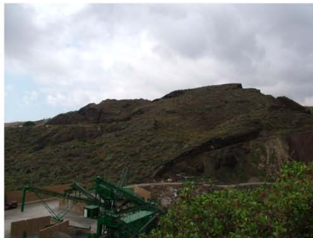
Figura 5.95: Vista general de los centros de eruptivos adosados de Sima Jinámar, delimitando en línea discontinua el contacto entre los conos. En el primer plano de la imagen, es el edificio localizado más al Norte el cual presenta el vaciado del conducto alimentador (flecha).
