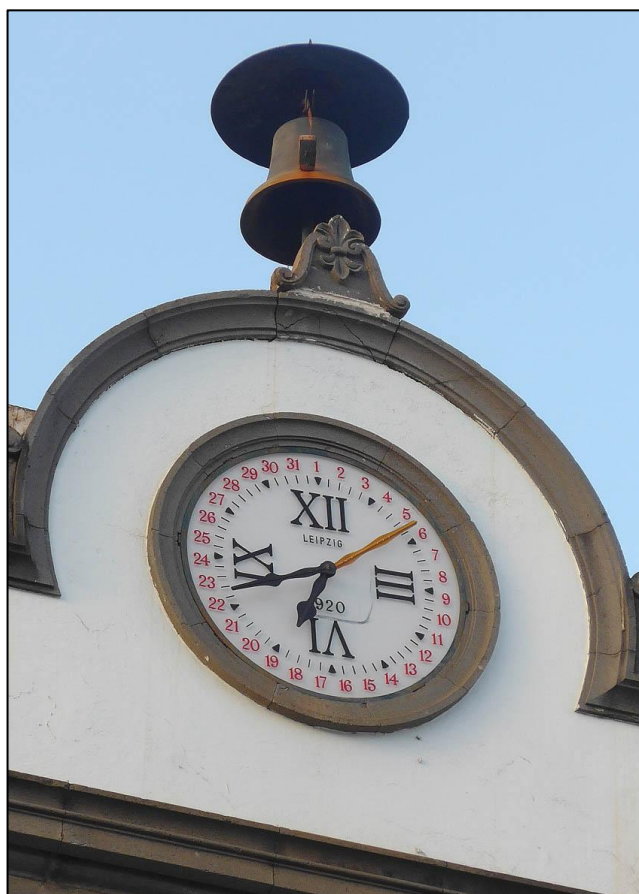
Figura 173. Campana del edificio de la Heredad de Aguas de Satautejo y La Higuera, Santa Brígida (Gran Canaria).
