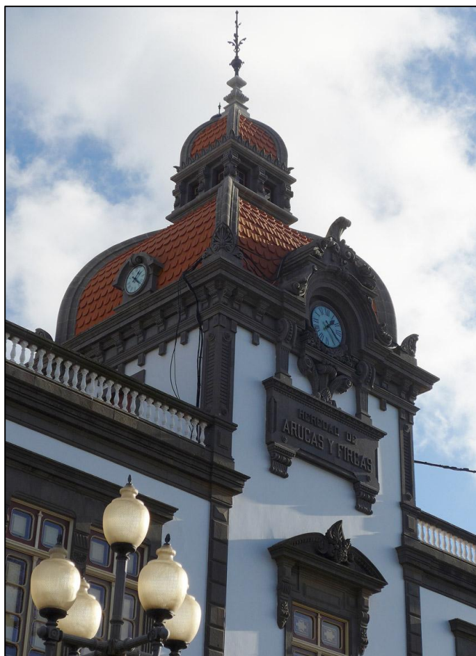
Figura 50. Torreón del edificio de la Heredad de Aguas de Arucas y Firgas, Arucas (Gran Canaria).
