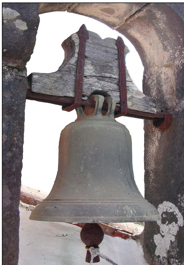
Figura 243. Campana de la ermita de San Isidro (San Isidro, Arbejales), Teror (Gran Canaria).
