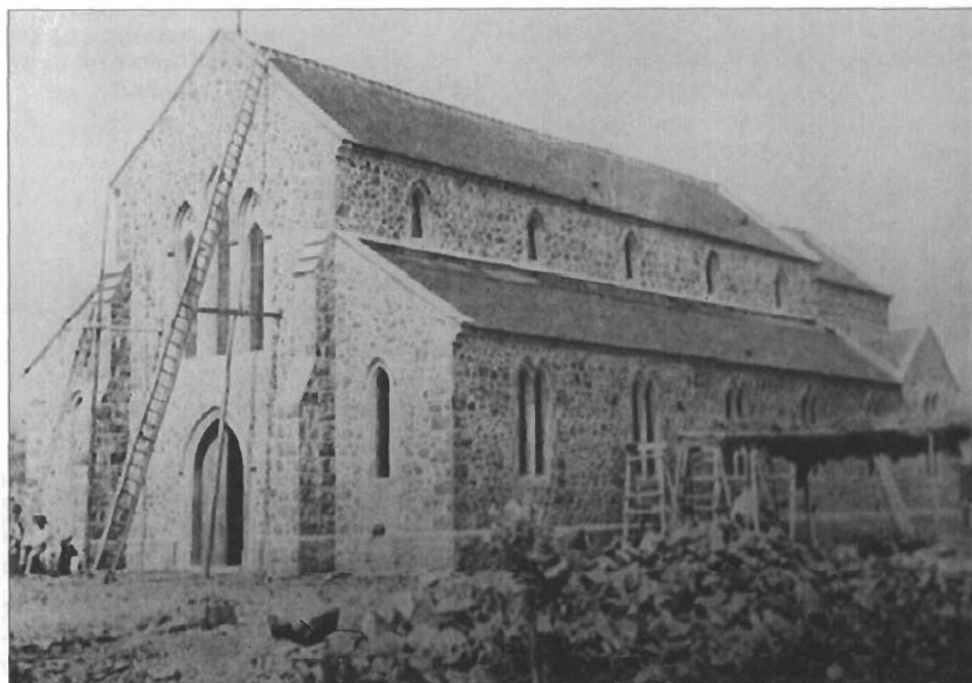
Construcción de la iglesia anglicana del Puerto de la Cruz (Tenerife). Obras dirigidas por su arquitecto, Walther I. Wood (1890).
