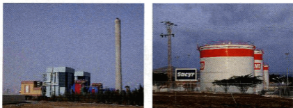
Foto II.8. Central Térmica de Juan Grande y Depósitos de combustible. Autor: C. Moreno.
