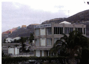
Foto II.10. Estación Depuradora de Aguas Residuales. Barranco Seco
