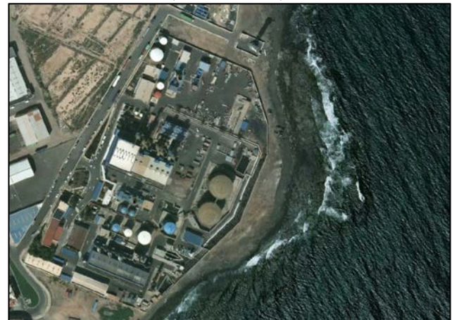
Figura 2. Planta potabilizadora de Puerto del Rosario (Fuerteventura)
