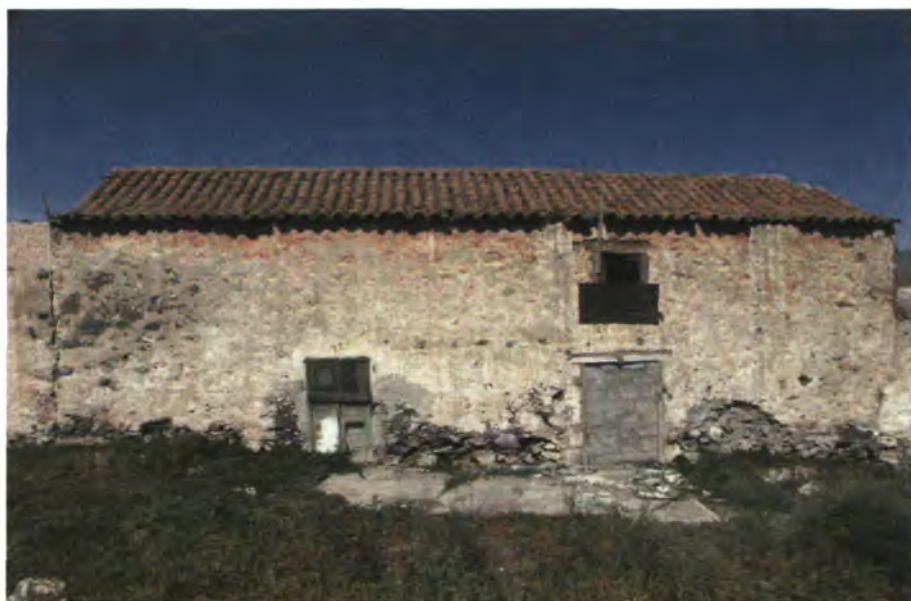
Fachada principal de las casas de la huerta episcopal, conformada por dos pisos cubiertos con techo a dos aguas. En ella se aprecia la sencillez de los acabados y la carencia de cualquier adorno. Los vanos están efectuados en función de las necesidades de sus moradores.
