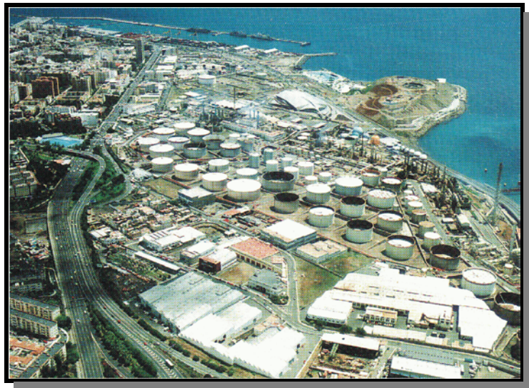
Vista aérea de la Refinería
