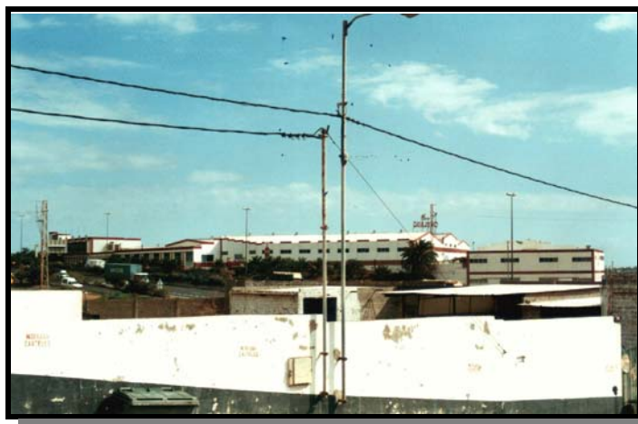
Vista parcial del polígono industrial de Salinetas
