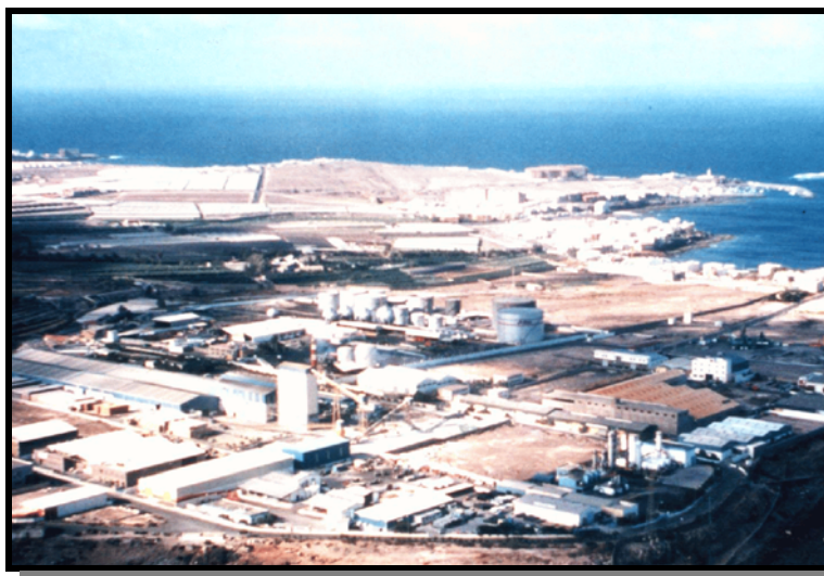
El desarrollo urbano en la costa de Telde en torno a la Autovía GC-1 encuentra una relación estrecha con el proceso de creación del amplio suelo industrial. (Entorno de Salinetas). Foto del autor.
