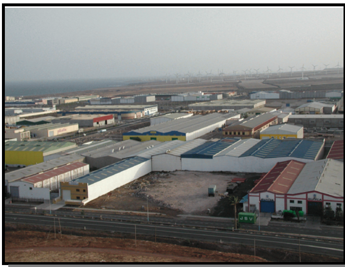
Vista del polígono industrial de Arinaga
