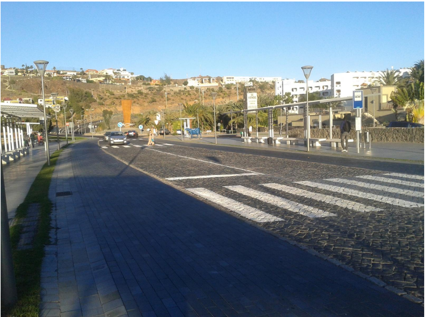
Figura 6. Rehabilitación de la GC-500 a su paso por San Agustín. Fuente: Juan M. Parreño.
