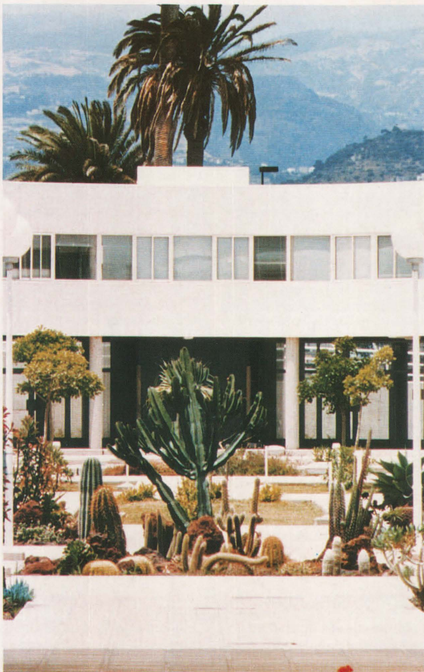
Edificio de Ingenierías.
