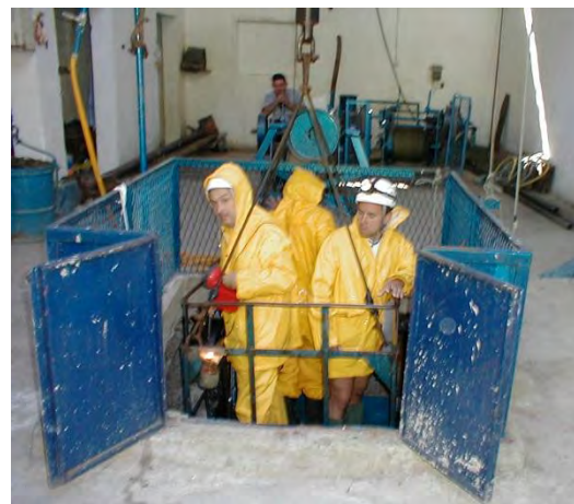
Figura 42.- Descenso para control de pozo. Detalle de equipamiento (Foto del autor)
