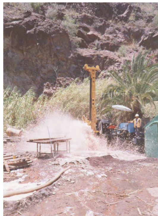
Figura 22.- Maniobra de "lavado del sondeo" (Foto del autor)
