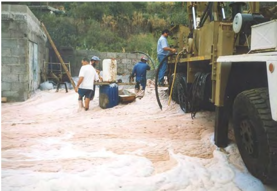
Figura 25.- Tareas de perforación (rotopercusión) (Foto del autor)
