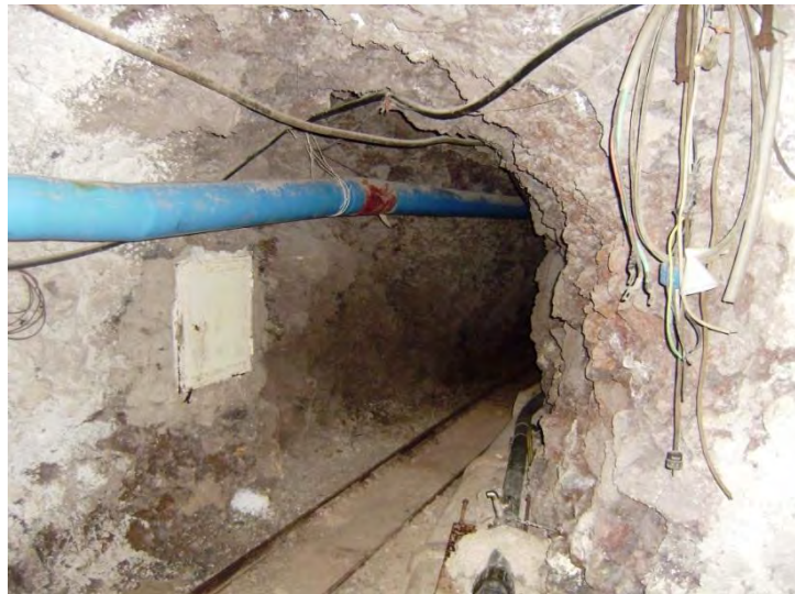
Figura 26.- Galería (Foto Antonio Medina, Vigilante Aguas y Cauces CIAGC)
