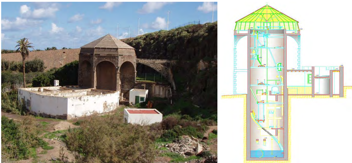
Figura 4.- Vista General y plano de propuesta de rehabilitación del Pozo de La Noria de Jinámar (detalle plano de Villar, 2007)
