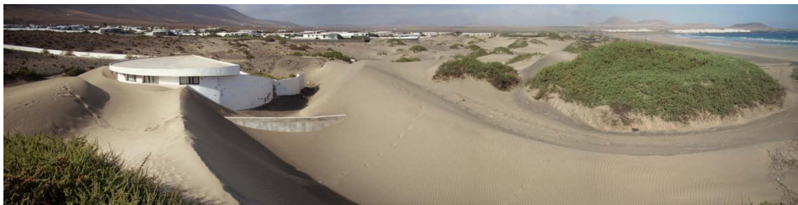
Figura 6.3. Zona norte de la urbanización Famara enterrada bajo la arena.
