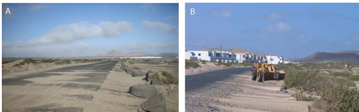
Figura 6.5. A) Rocas en la parte norte de la carretera que une la urbanización Famara con Caleta de Famara. B) Maniobra de extracción del sedimento de la parte norte de dicha carretera.
